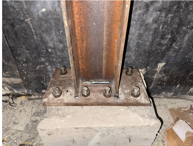
Gambar 2. Sambungan H-BEAM Terpasang Secara Simetris
