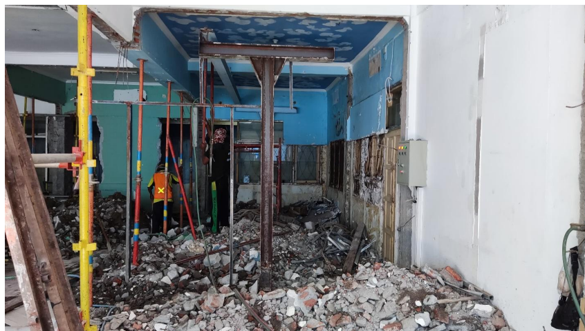
Gambar 3. Pelepasan H-BEAM
