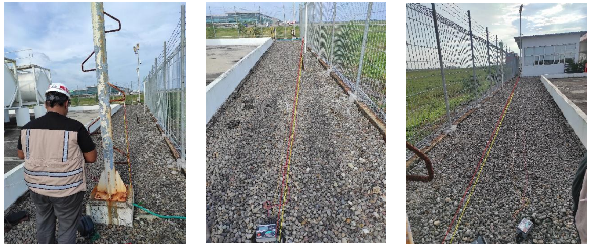
Gambar 1. Uji Grounding Untuk Penangkal Petir
