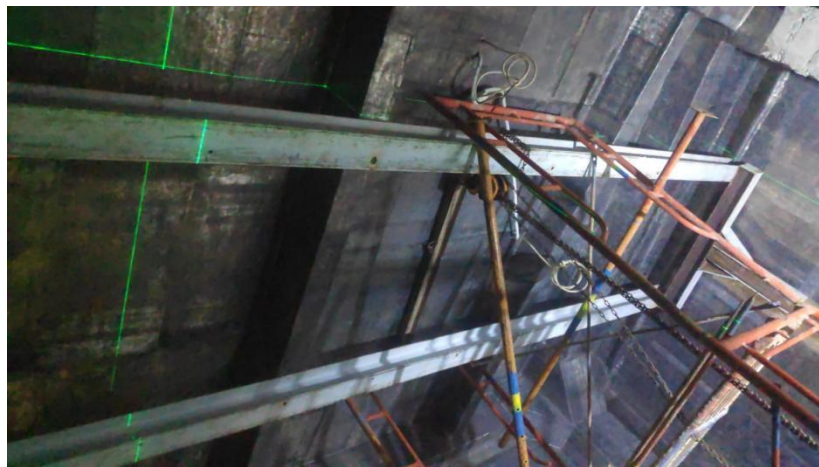
Gambar 4. Pengecekan Struktur dan Kestabilan
