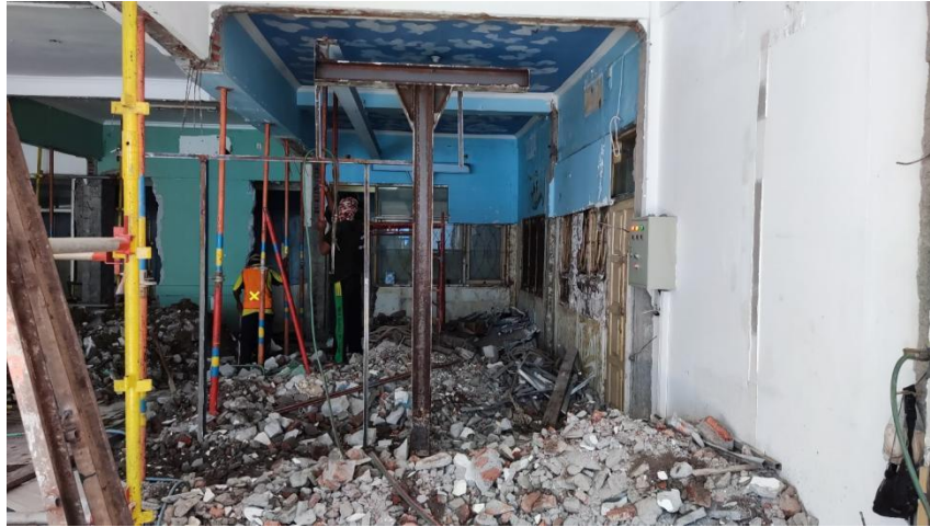
Gambar 3. Pelepasan H-BEAM
