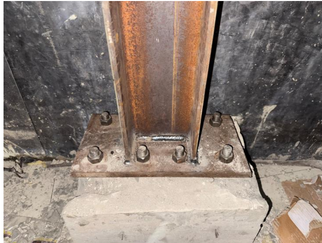
Gambar 2. Sambungan H-BEAM Terpasang Secara Simetris
